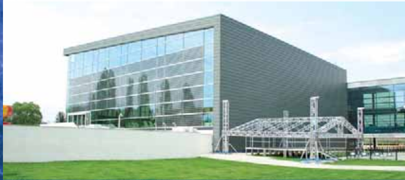
Fotovoltaická fasáda: Presklená stena Blue Sapphire obsahuje integrované fotovoltaické články.
