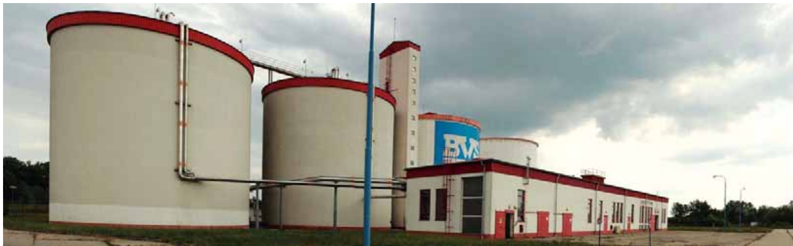
Do Dunaja síce vyteká čistená voda, ale problém s kalom zostáva. Preto sa vybudovali tri vyhnivacie a jedna uskladňovacia nádrž.
